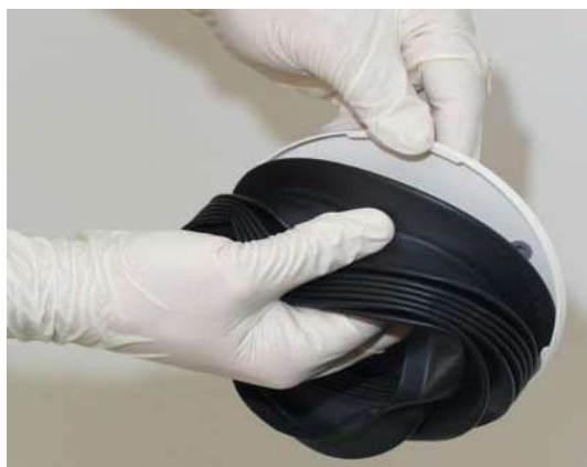
РИСУНОК 7-7 Отсоединение верхней панели от сифона
